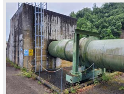
Übergang zwischen über- / unterirdischer Verlegung mit großem Widerlagerblock
