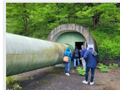
Beginn eines Streckenabschnitts in einem langen Stollen
