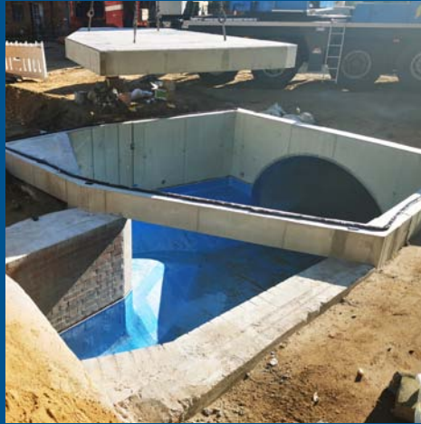
Schachtbauwerk in offener Bauweise, Pontekanal, Foto Amiblu Germany
