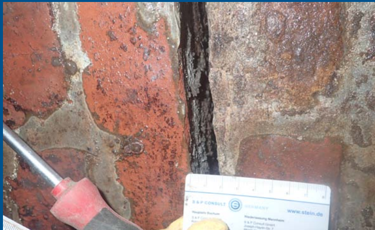
Abb. 1: Bauwerks- und Baugrunderkundungen in der Karlsruhestraße
